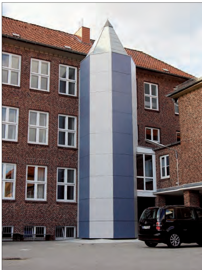
Hiort Lorenzen-Skolens nye vartegn: En elevatorskakt, der er udformet som en godt 14 meter høj blyant
